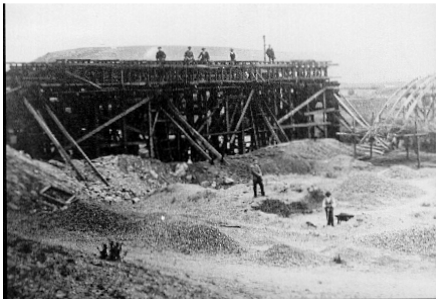
Fotografía 1 Construcción del puente de Traiguén
