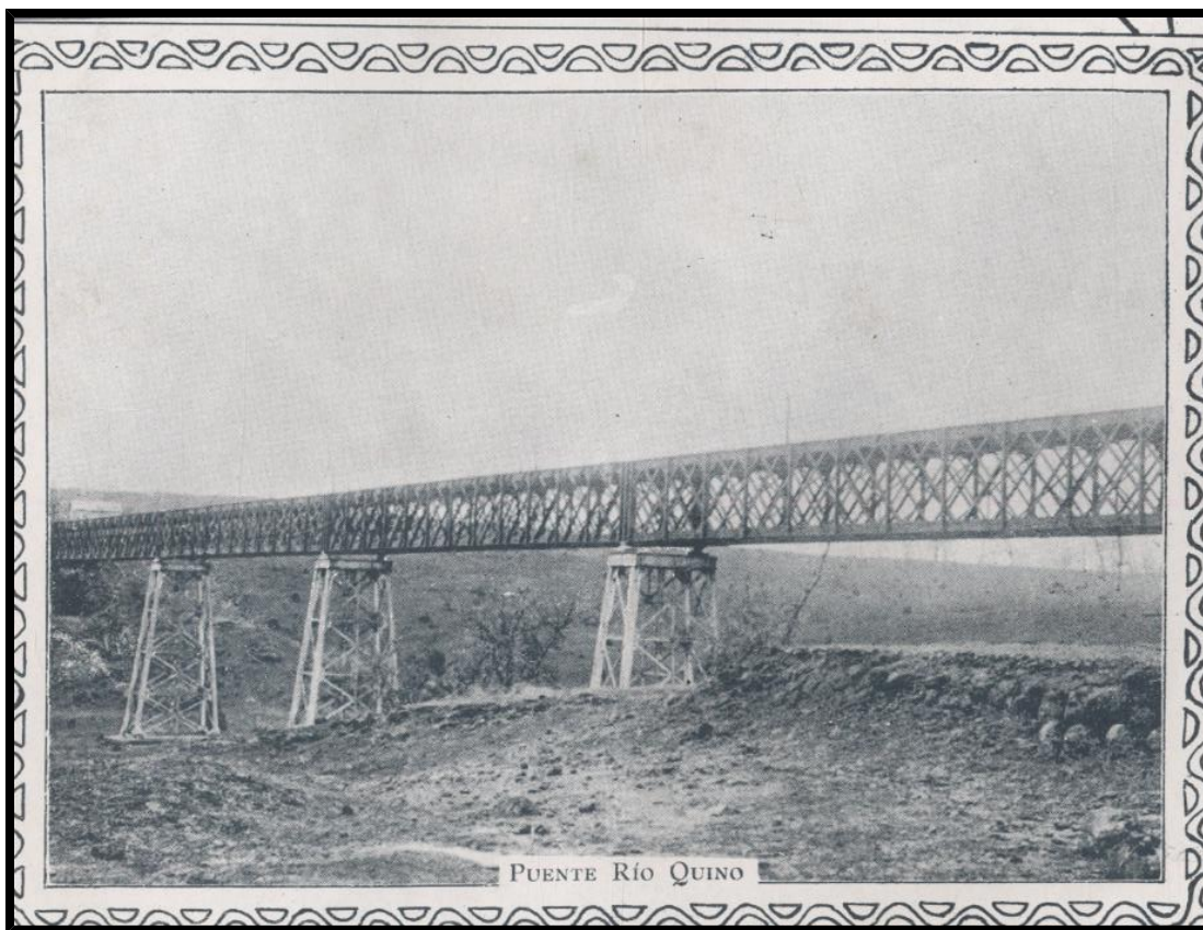
Fotografía 5 Puente ferroviario río Quino, Album obras públicas , 1910
