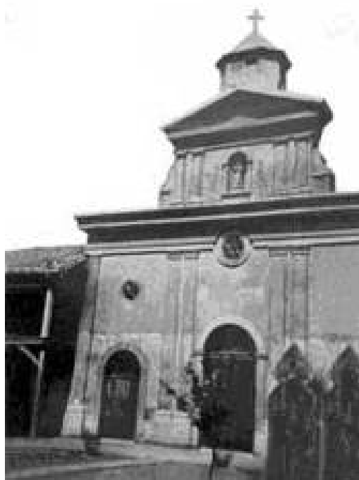
Fotografía 1, Templo San Leonardo de Porto Mauricio de Collipulli antes del terremoto en 1960 cuando se cayó la cúpula. Autor desconocido.
